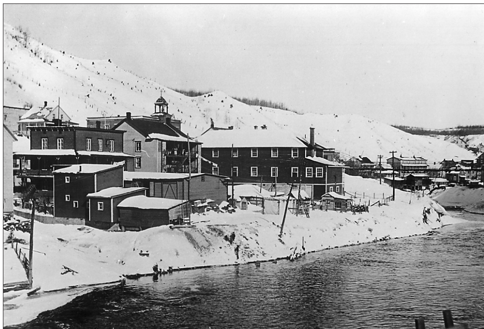
Cette photographie prise le 5 février 1926 nous montre le village de la Baie de Shawinigan juste avant l'agrandissement de l'usine Belgo au cours de la même année. Un nouveau bâtiment sera érigé pour permettre l'installation des machines à papier numéros 7 et 8.
