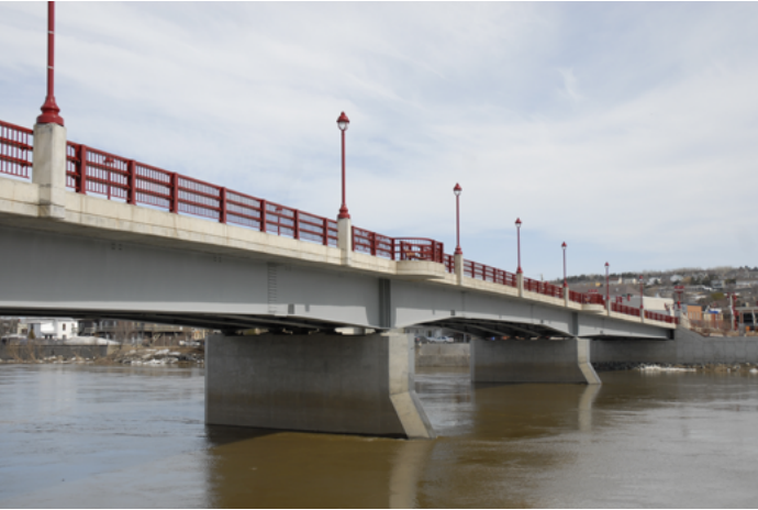
P-10861 Municipalité de Sainte-Marie, en Beauce, au-dessus de la rivière Chaudière
