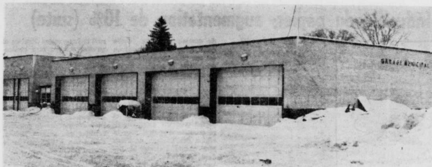
Le garage municipal, à Windsor, est construit en fonction d'une intervention prompte et efficace des employés de la voirie.
