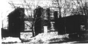
25 Champlain, Victoriaville 3 logements, en brique. Const. 1964. Chauffage eau chaude.
