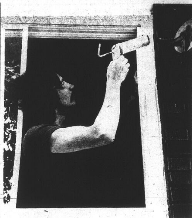
Les fenêtres et le calfeutrage couverts par le programme provincial d'isolation.
