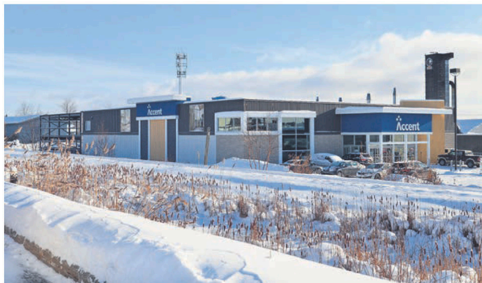
Les travaux d'agrandissement s'effectuent à l'arrière du magasin.
