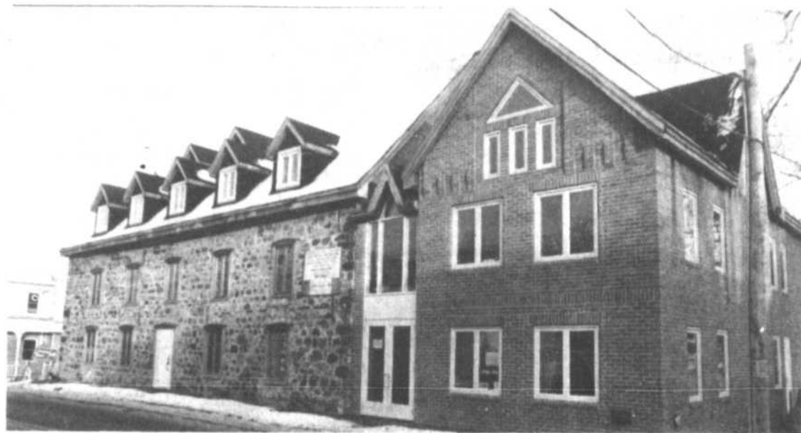
La députée Luce Dupuis devait, selon l'architecte Hubert Chamberland, installer ses pénates dans le Vieux moulin, mais a choisi un local ailleurs.
