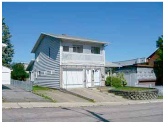
Maison de la rue Saint-Rédempteur à Beauport
