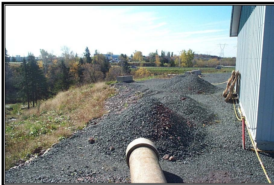
Photo 4 : Distance entre l'arrière du 366, chemin Harlaka et le glissement de terrain
