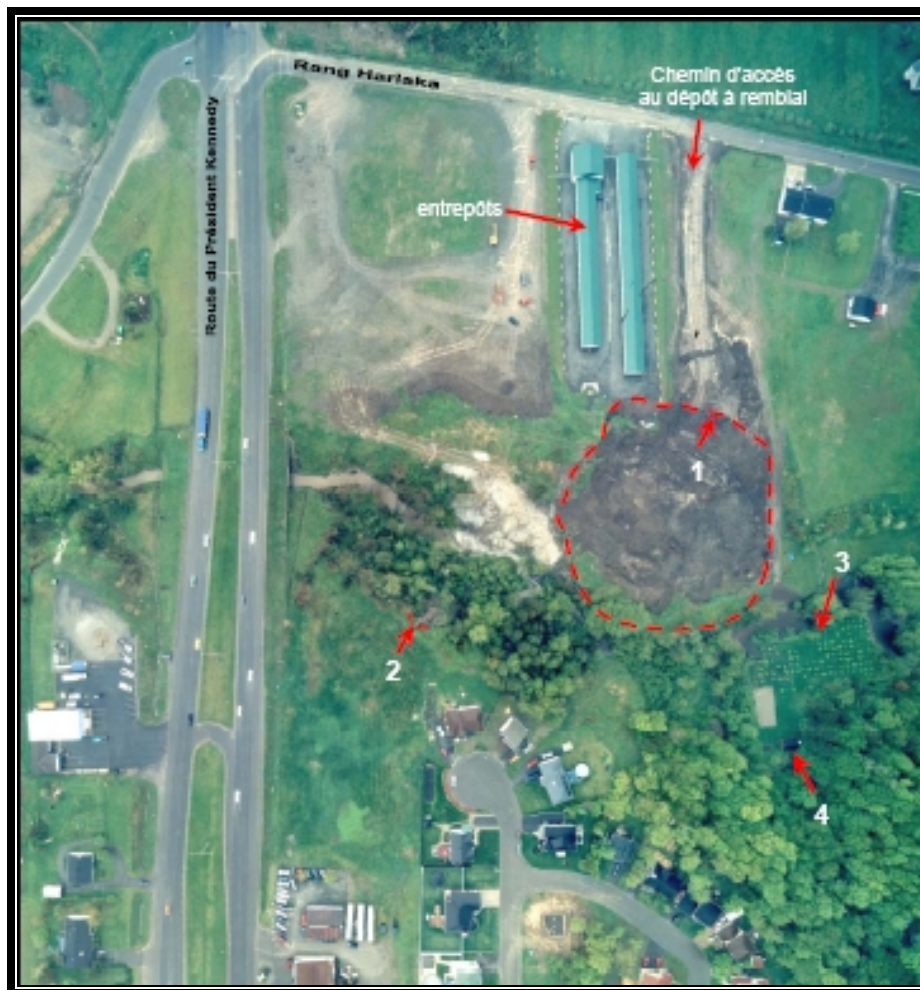
FIGURE 1 : VUE AÉRIENNE DU SECTEUR DE LA RIVIÈRE DES COUTURE
