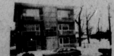
36 - RIVE-SUD - Construction brique, 6 confortables logis de 4 1/2 pièces chacun, rapportant $13,000 par an, beau secteur $12,000, suffit pour l'acheter. (MLS) MICHEL BAHL 658-0628
