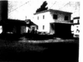
334 Principale, Daveluyville Maison de chambres, salle à diner et restaurant, prix avantageux. Comptant à discuter.
