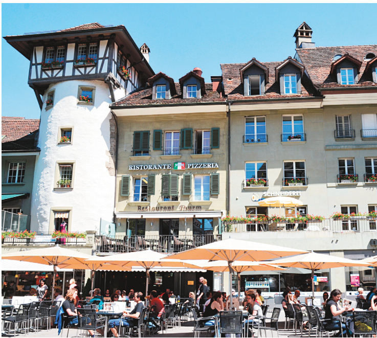
La tour hollandaise de Berne coiffée d'un étage en charpente.
