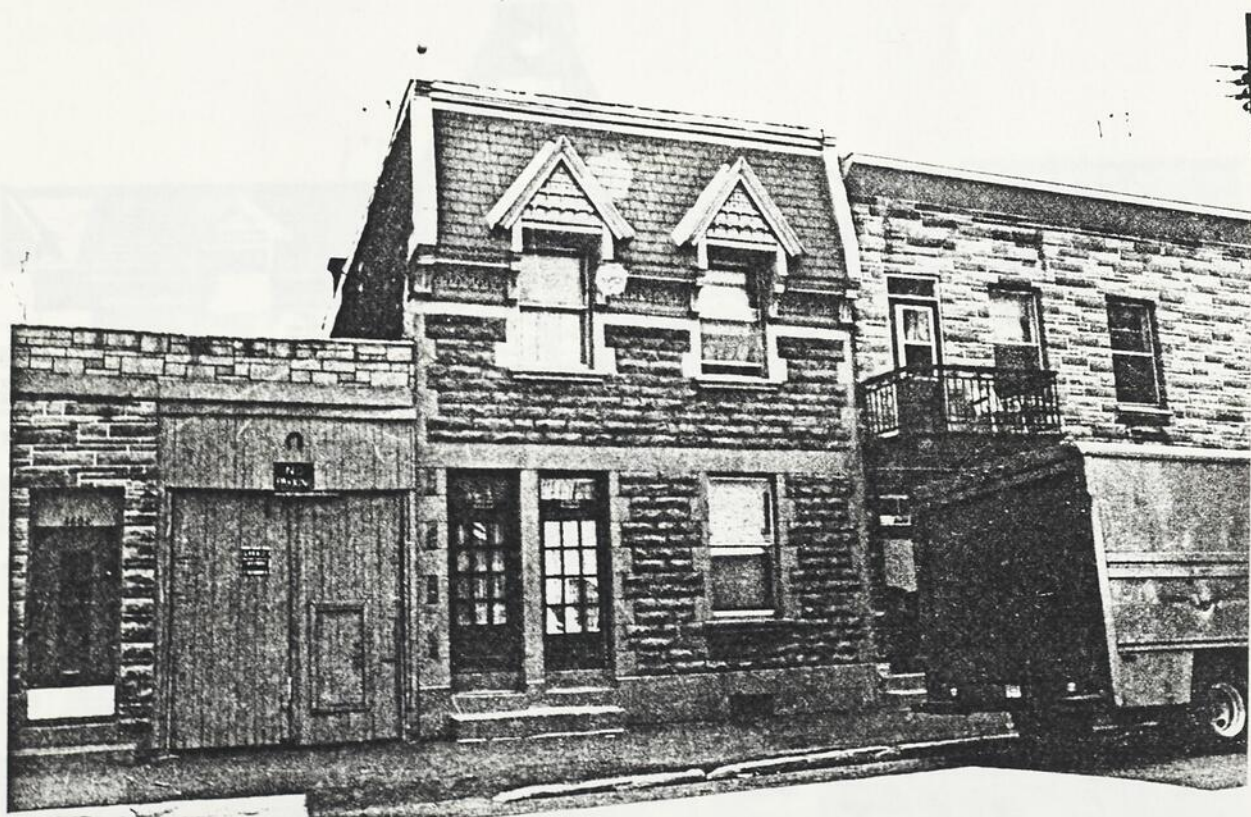
Fig. 54 Maison, 4610-2 de Bullion.
