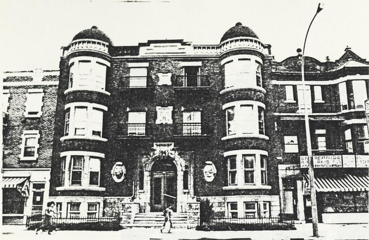
Fig. 42 Edifice de rapport, 5415 du Parc.
