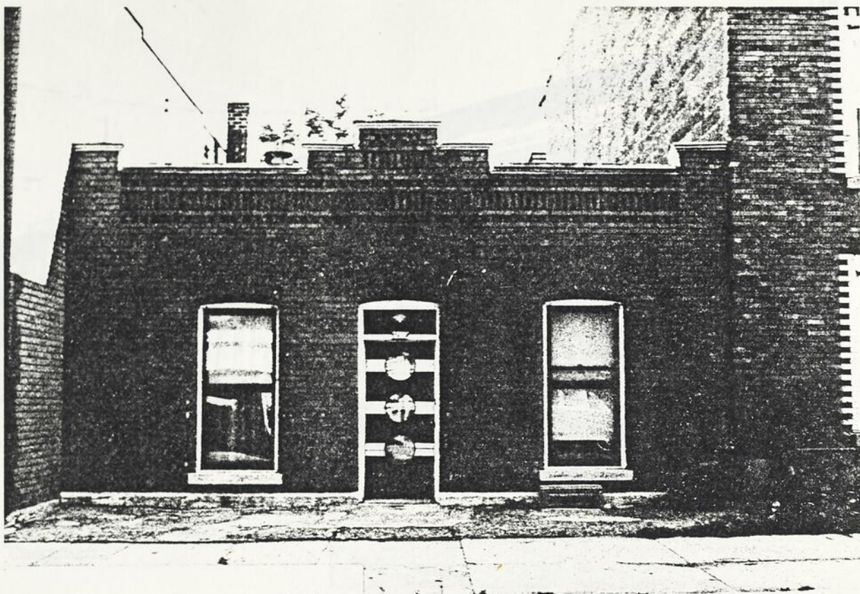
Fig. 24 Maison unifamiliale, 6589 de Gaspé.
