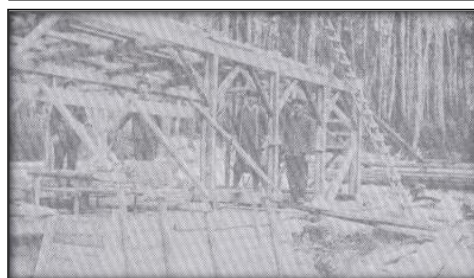
Moulin à scie portatif en construction
