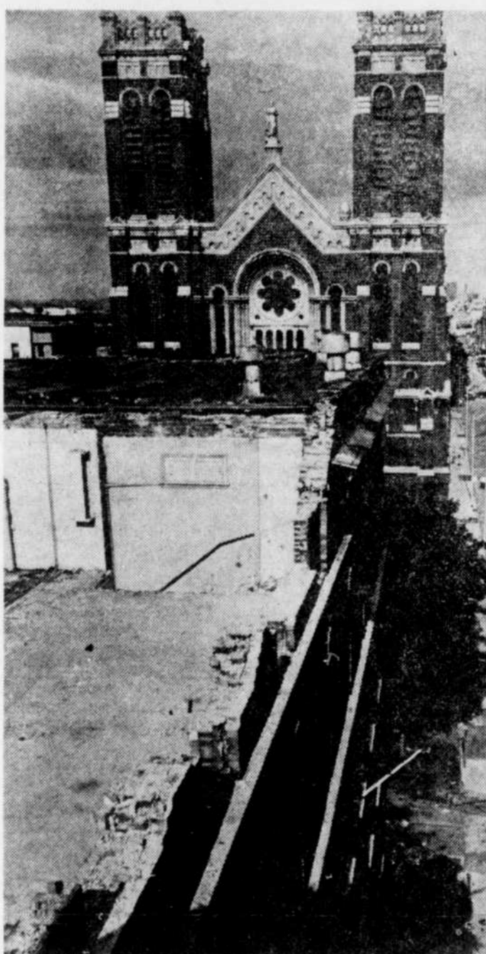
AVEC DU VIEUX ON FAIT... — L'ancien couvent Saint-Roch, qui était devenu une desserte du Cegap Limoilou, tombe sous le pic des démolisseurs. C'est à cet endroit que s'élèvera le nouveau Holiday Inn de centre-ville, dans la capitale.
