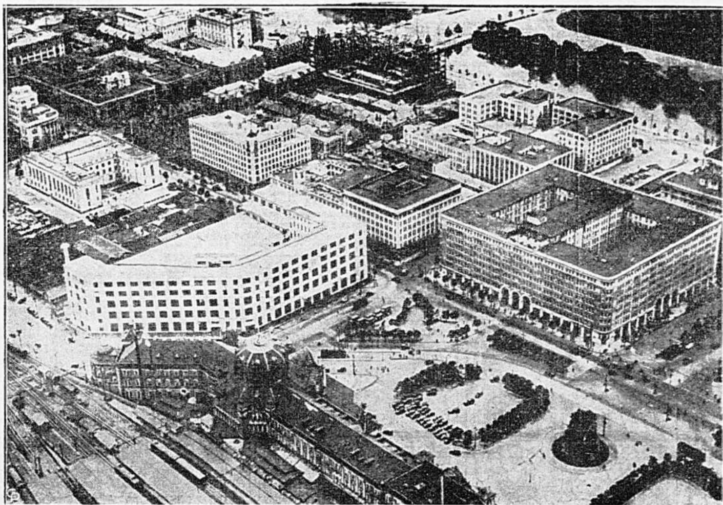
Voici une vue d'ensemble de la ville de Tokio, au Japon, où les autorités ont ordonné l'extinction de tous les feux, la nuit, au cas d'une attaque aérienne de la Russie à la suite des multiples incidents de frontières qui se sont déroulés ces jours-ci.
