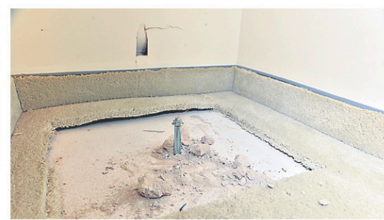
Le coffre-fort a été arraché du sol dans la garde-robe.
