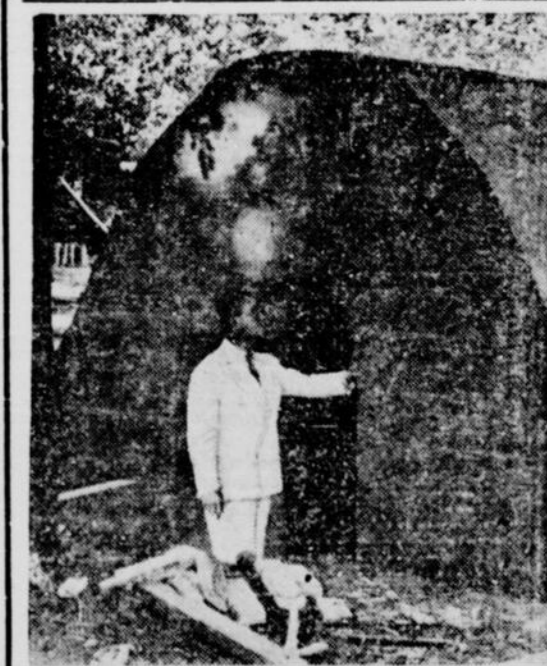
Un inventeur suédois, KARL B. PILLNER, vient d'inventer cette forteresse qu'il construit en quatre heures par un procédé absolument nouveau. Le système qu'il emploie fait durcir en 4 heures l'enduit qui nécessite habituellement plusieurs jours. On pourra ainsi édifier dans une nuit des abris à l'épreuve des bombes, tel que l'ont démontré les expériences conduites à ces fins par les autorités militaires.
