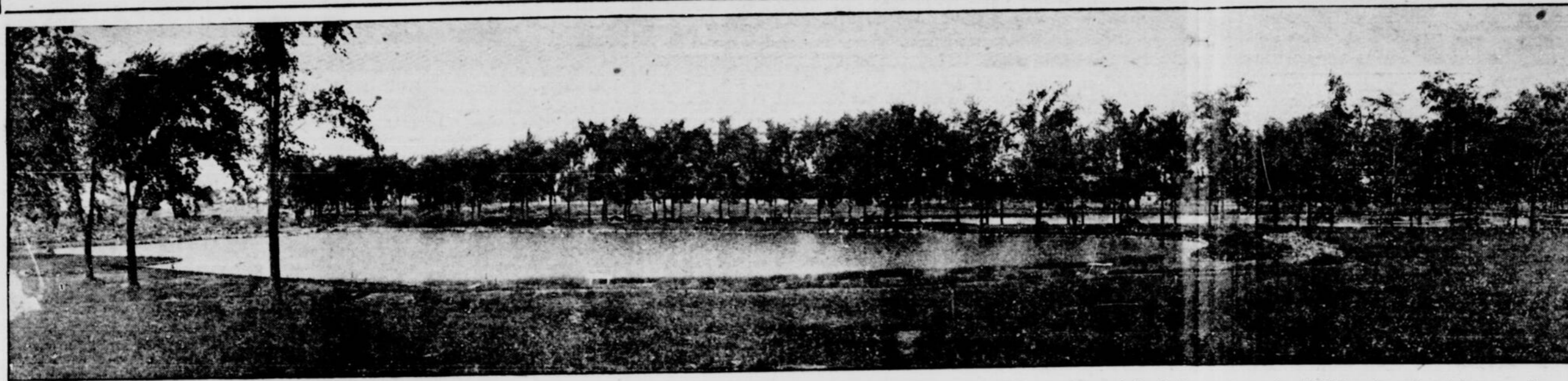
L'aspect général que présente le grand lac artificiel au Jardin Botanique de Montréal, dont les travaux d'aménagement viennent d'être terminés. Non seulement le lit du lac a été creusé, solidifié et cimenté, mais la nappe d'eau se fait admirer depuis quelques jours par une foule de visiteurs, qui ont été particulièrement nombreux hier après-midi. Cette nappe d'eau représente une superficie de 1500 pieds environ. (Photo la "Patrie").
