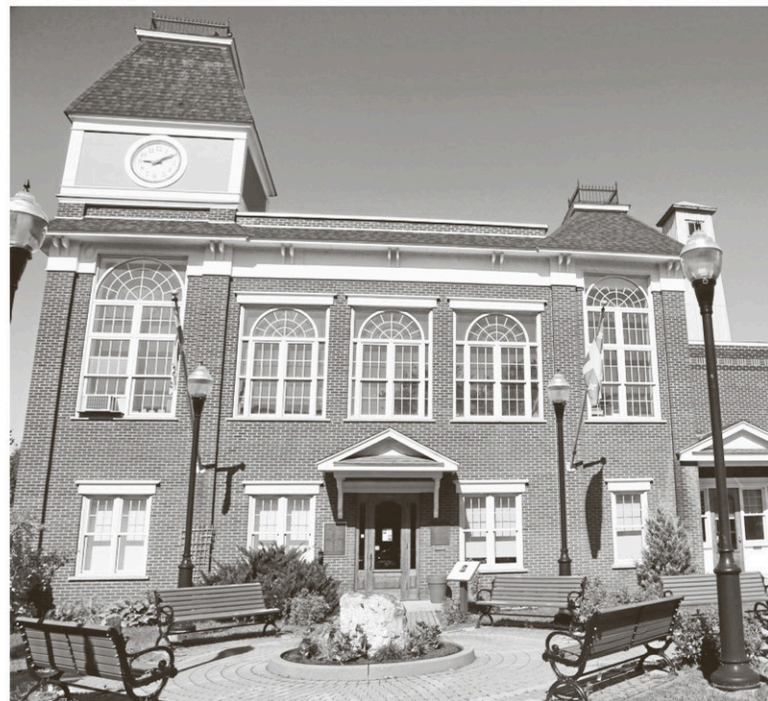
Plusieurs problèmes aux structures de l'hôtel de ville de Sutton ont été découverts lors des travaux de rénovation de la bâtisse construite il y a 159 ans. — PHOTO ALAIN DION ARCHIVES LA VOIX DE L'EST
