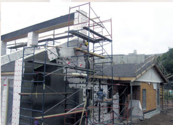
Construction du pavillon Georges-Dor.
