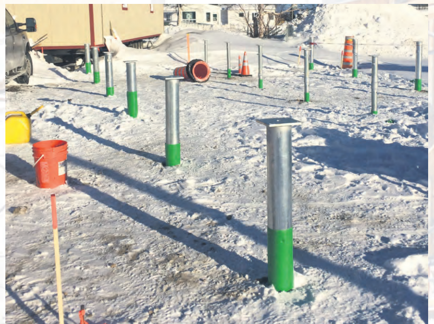
Installation de pieux commerciaux.
