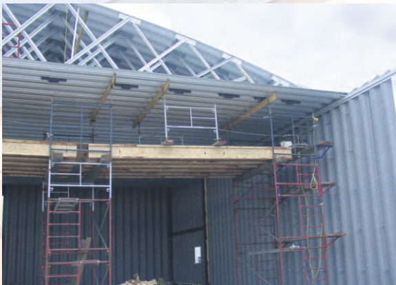
Construction de bâtiment Exact Air à Pointe-Lebel.
