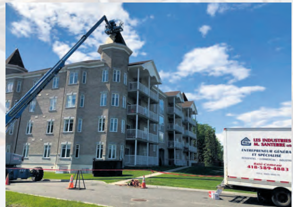
Réfection toiture Château Comeau.
