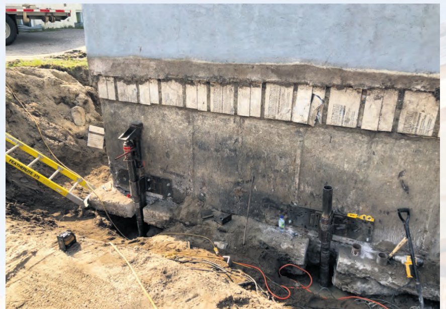
Stabilisation et mise au niveau d'une fondation.
