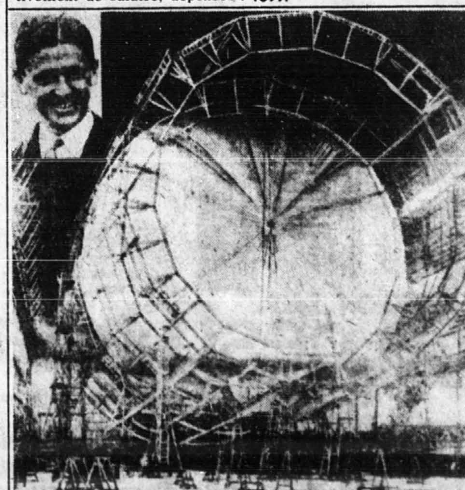
Le R-101 que l'on voit ici est le plus gros vaisseau aérien du monde. Construit par le gouvernement britannique pour des envolées expérimentales sur la route Angleterre-Egypte-Indes, il a été inspecté ces jours derniers à Cardington. D'une longueur de 750 pieds, ce ballon a une capacité de gaz de 500,000,000 de pieds cubes. En haut, à gauche, le pilote du R-101, le lieutenant aviateur H.C. Irwin. Cette photo a été publiée avec cette légende le 5 septembre 1928.
