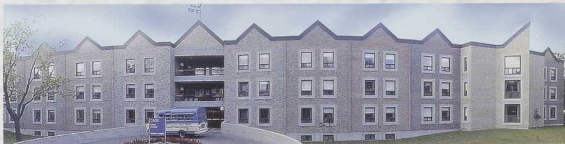
Centre d'accueil Armand Lavergne, Montréal Cinq couleurs de briques utilisées
