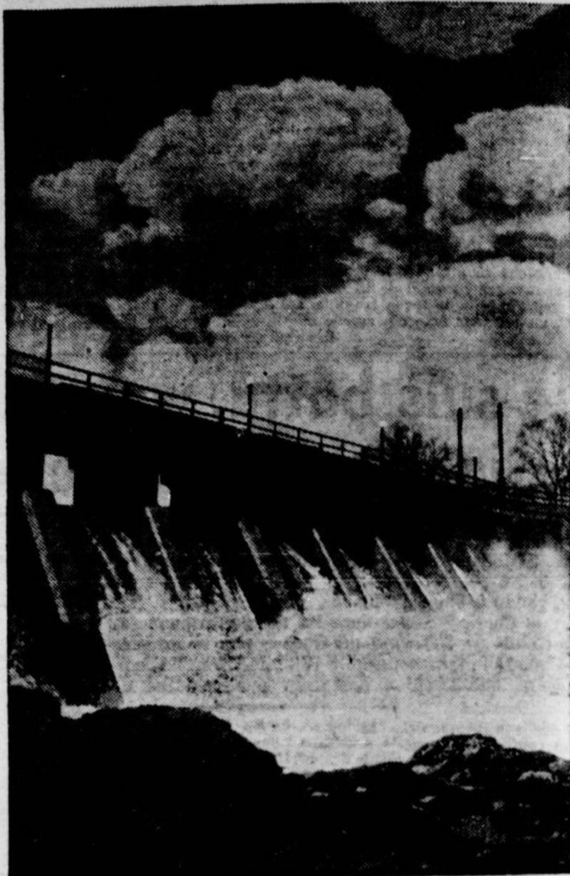
Le barrage de St-Jérôme alimenté par des centaines de ruisseaux de montagne
