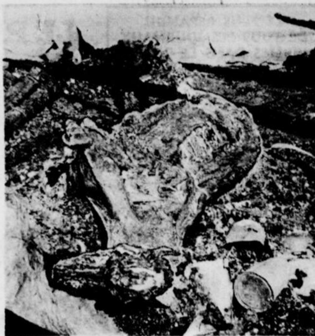
Voici tout ce qui reste d'un bâtiment rasé au sol par les flammes. Des débris et six chevaux calcinés. La photo nous fait voir le cadavre de l'une des pauvres bêtes.
