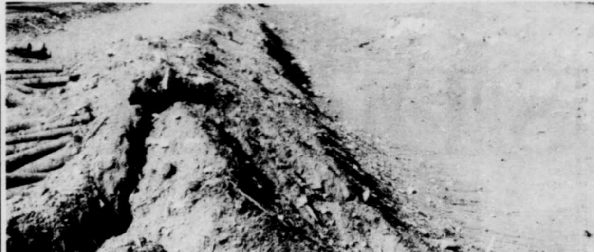
Cette tranchée d'enfouissement, d'une longueur d'environ 1,000 pieds, est prête à recevoir les déchets des 13 municipalités que des-
