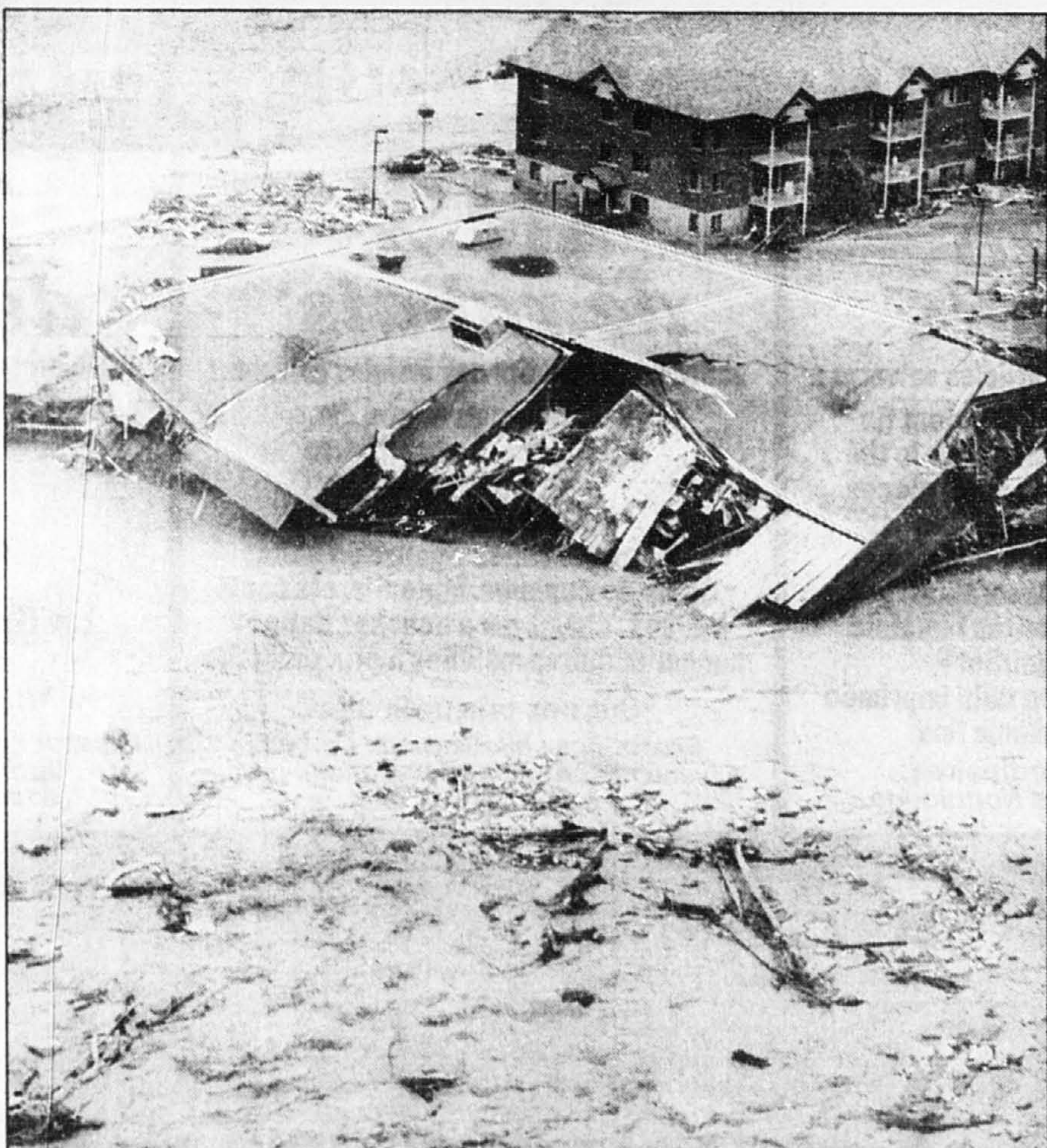
Un des nombreux immeubles qui se sont effondrés à La Baie. Déjà samedi soir, le maire de la Ville, Claude Richard, chiffrait les dommages en dizaines de millions de dollars. Une caisse populaire, une station-service avec dépanneur, plusieurs maisons et deux ponts ont été emportés.
