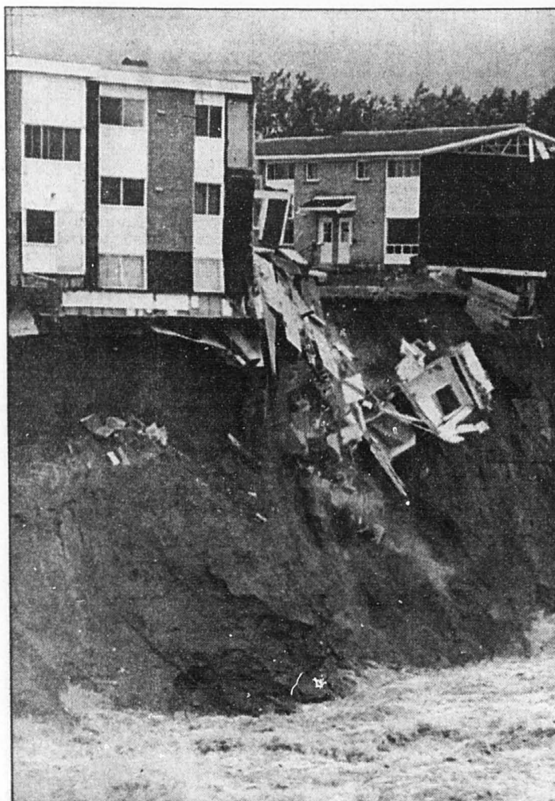
Une partie d'un HLM de Jonquière s'est effondrée hier matin. PHOTO CP
