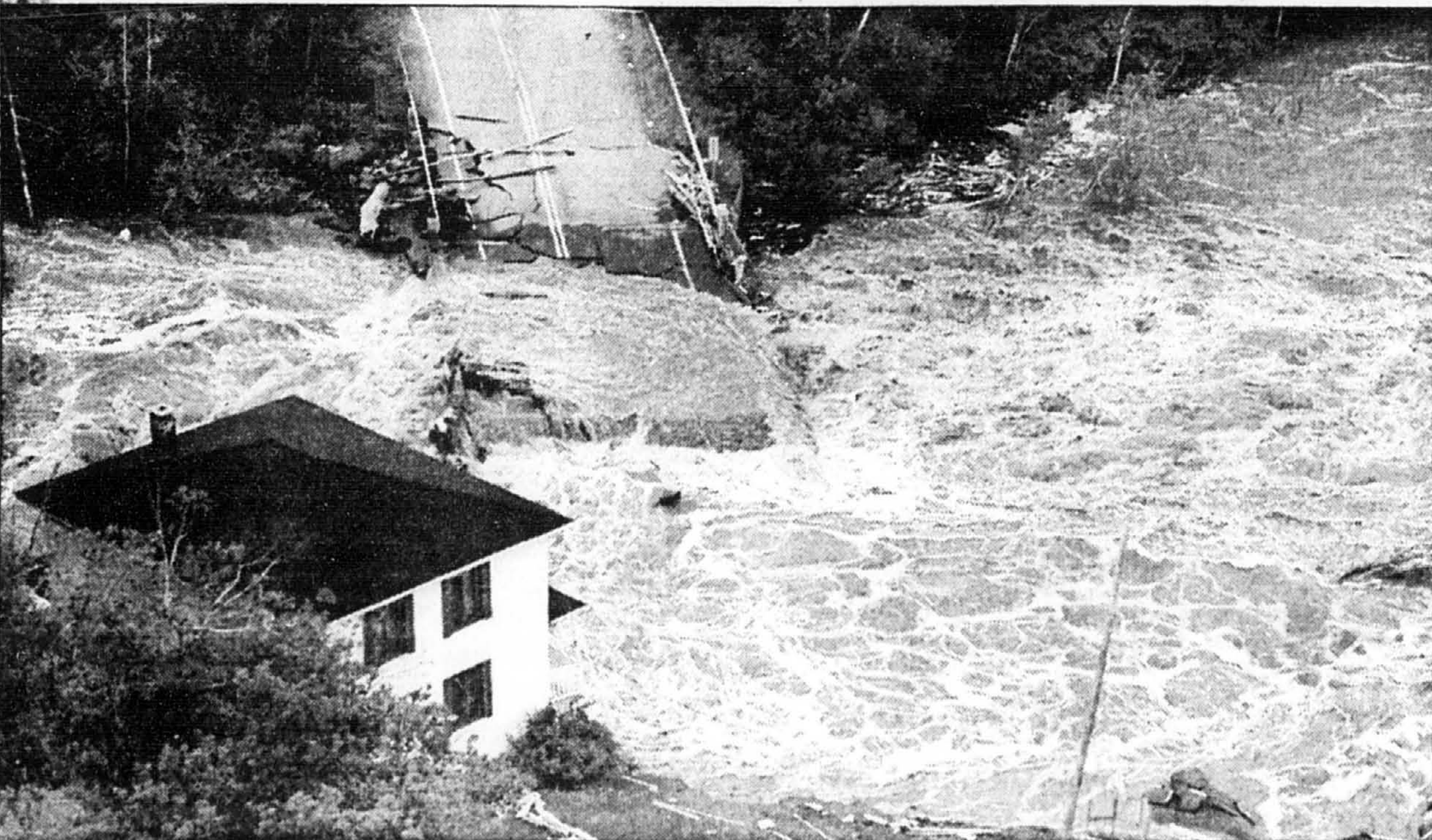
A plusieurs endroits, les routes et les ponts enjambant les rivières ont été tout simplement arrachés. Uniquement pour les ponts, les dégâts grèpent à des millions de dollars.
