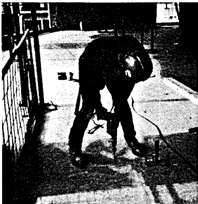
Figure 4 Installation du garde-corps après le bétonnage: perçement et pose de l'encrage. ("US patent 4830 341", "US patent 4787 475", «En instance de brevets au Canada»)
