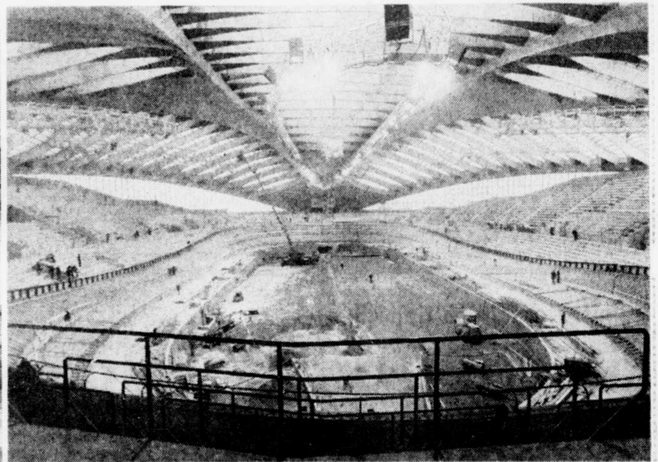
La piste ovale est en voie de construction dans cet édifice qui aurait dû être prêt il y a près d'un an.
