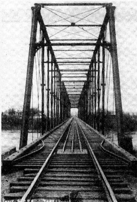
Le premier pont du chemin de fer érigé sur la rivière des Mille Îles à Terrebonne (photo d'avant 1900), a été remplacé plus tard par une structure beaucoup plus légère. (Photo : Collection Aimé Despatis, CRAL)
