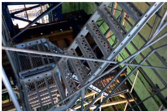
Source : Coffrage Alliance
