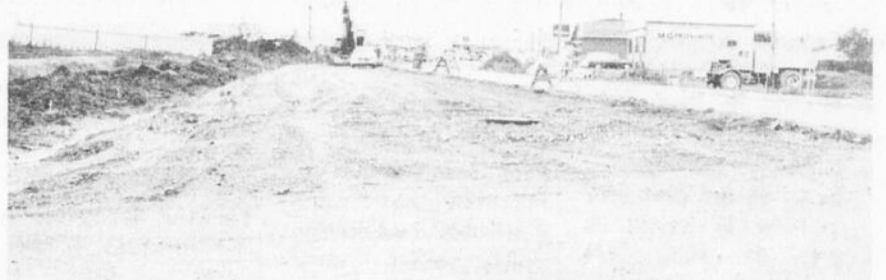
La Ville de Princeville profite des travaux effectués sur le Boulevard Baril pour apporter des améliorations à son réseau d'aqueduc.
