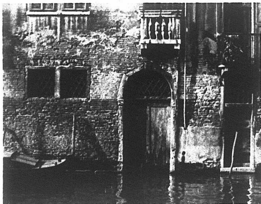
Le long du canal Saint-Laurent, une maison vénitienne qui accuse son âge.
