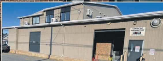
Quai de déchargement
