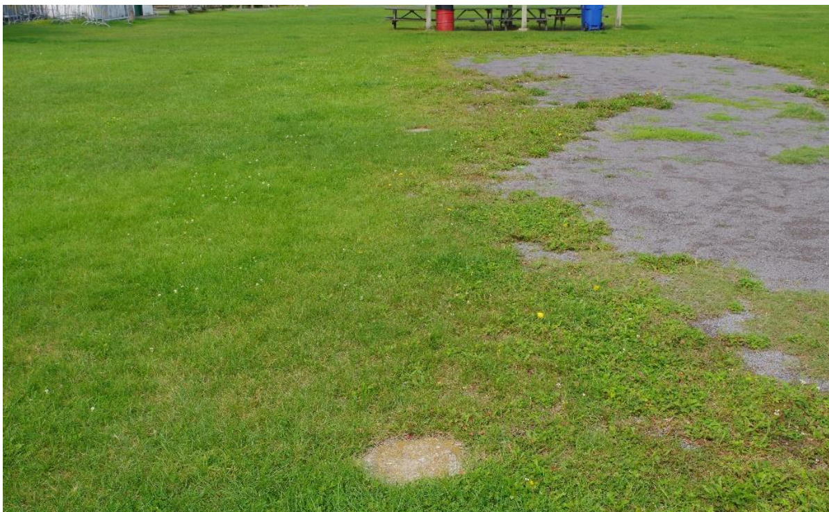
Figure 25 : Exemple d'une base en béton datant des années 1960-1970.
