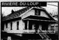
RIVIÈRE-DU-LOUP Rue Témiscouata : Résidence 1 1/2 étage avec intérieur chaleureux. Grandes pièces. Garage. Zonage artisanal. (2008)
