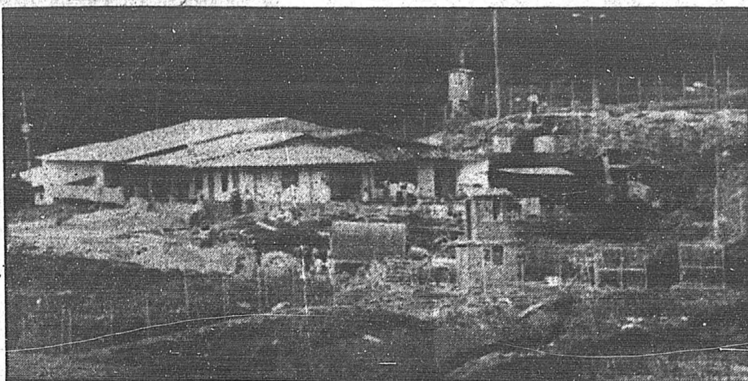
Des ouvriers terminent la construction du centre de réhabilitation qui deviendra la prison à sécurité maximale pour accueillir Pablo Escobar, dans sa ville natale d'Envigado.
