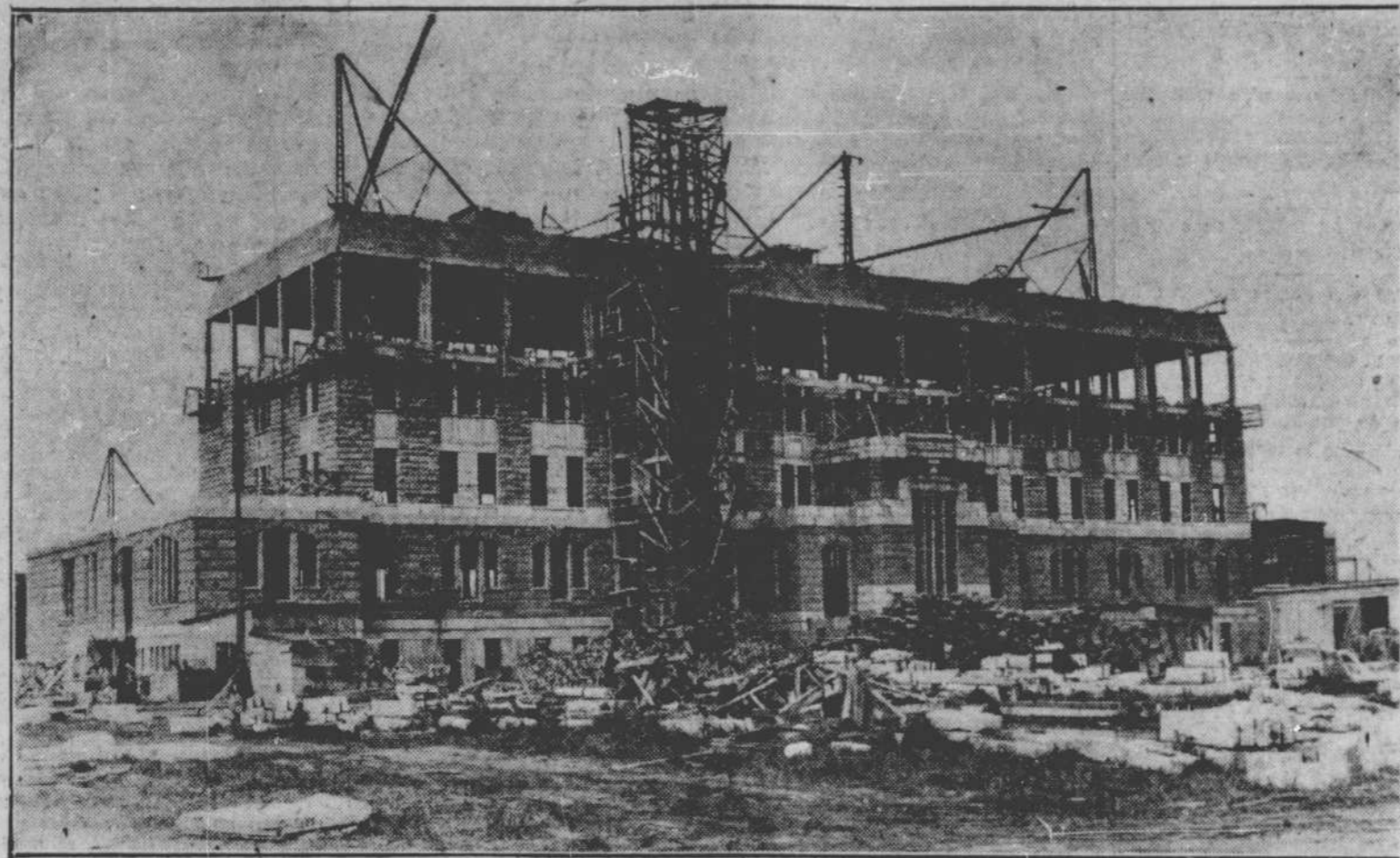
Les ouvriers de la maison EMILE FRENETTE, constructeur du nouveau collège des Jésuites, dans le quartier Belvédère, progressent rapidement dans l'exécution des travaux et la pierre est maintenant posée jusqu'au quatrième étage. M. FRENETTE veut fermer l'édifice avant l'arrivée des neiges afin de pouvoir travailler à l'intérieur durant l'hiver. Notre vignette montre les progrès de l'imposante construction. (Photo du "Soleil").
