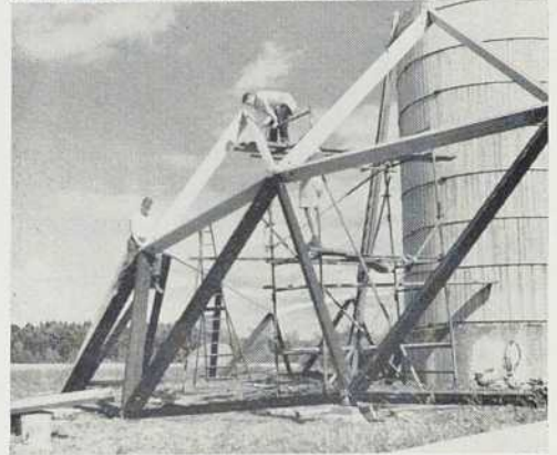
Détail de construction montrant l'échaffaudage mobile.
