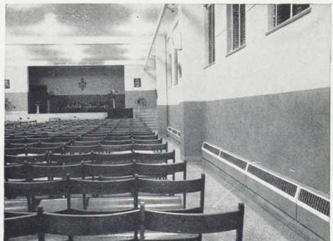
Installation de radiateurs à plinthes le long du mur d'une salle. (Cliché courtoisie Darling Brothers Limited).
