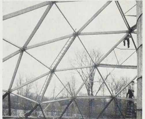
Détail de la charpente, vue de l'intérieur, montrant les échelles et les treillis.
