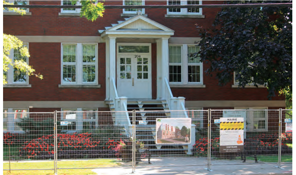
Les travaux sont amorcés pour agrandir la mairie de Saint-Basile-le-Grand. (Photo : Frank Jr Rodi)
