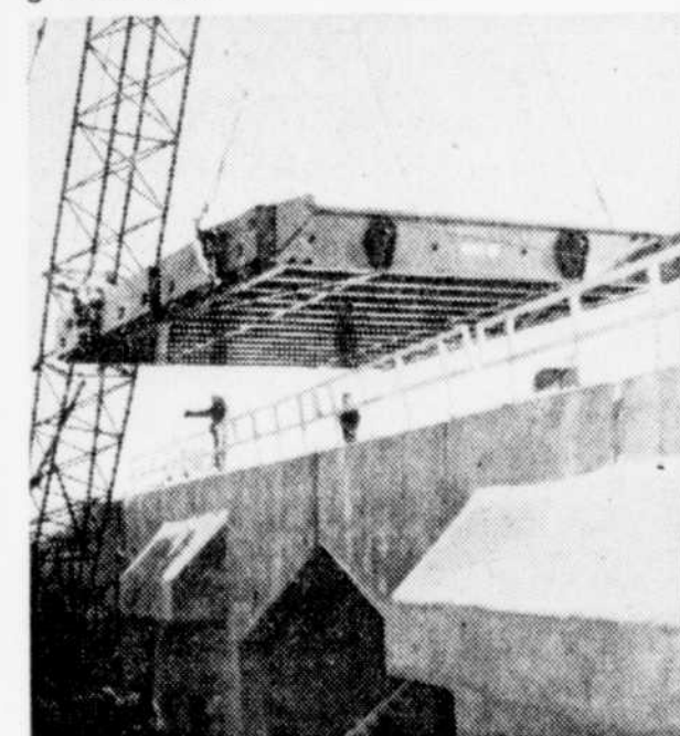
Conception, fabrication et installation des pièces encastrées et des vannes de prise d'eau
