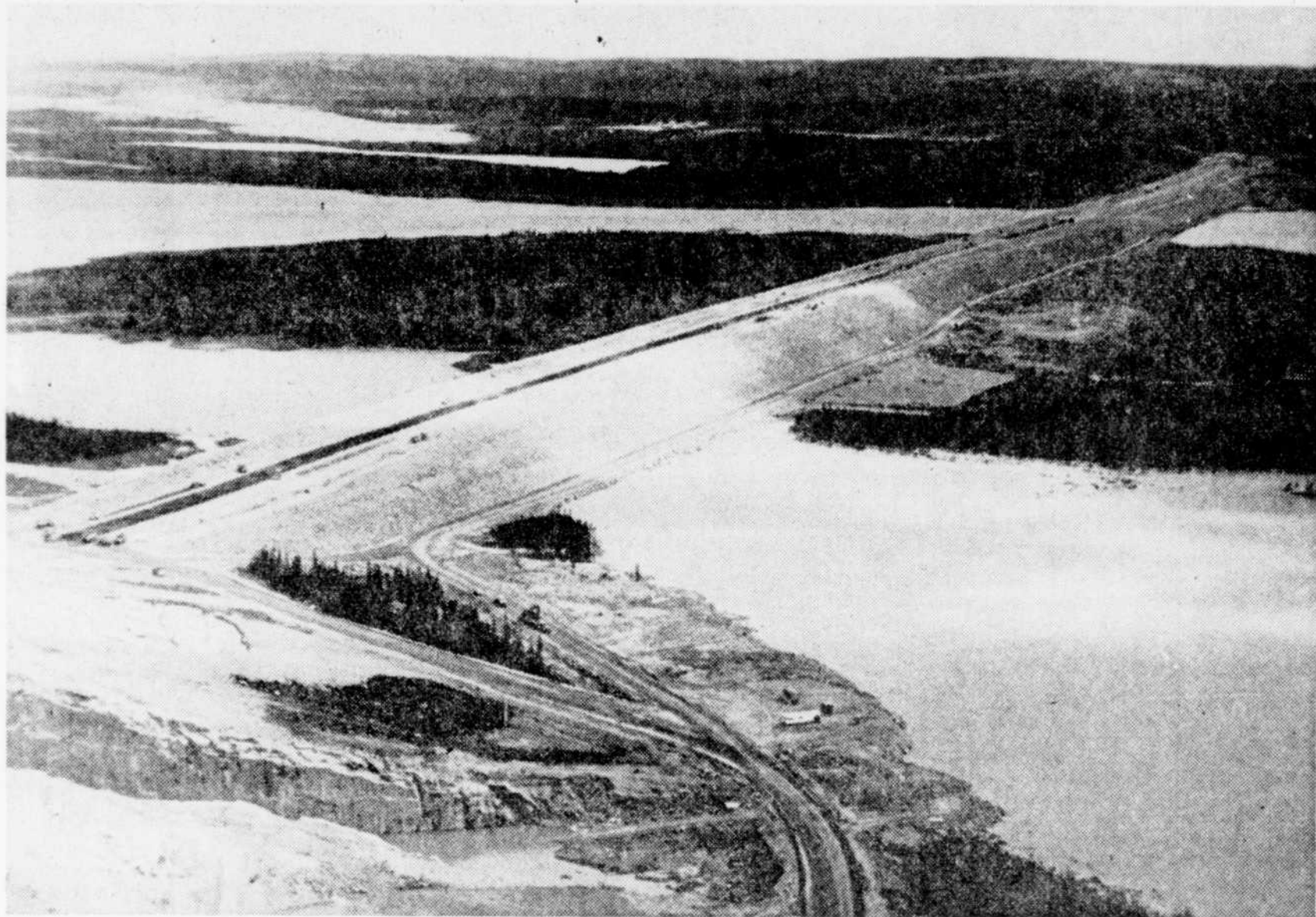
BARRAGE KA-3 CANIAPISCAU
