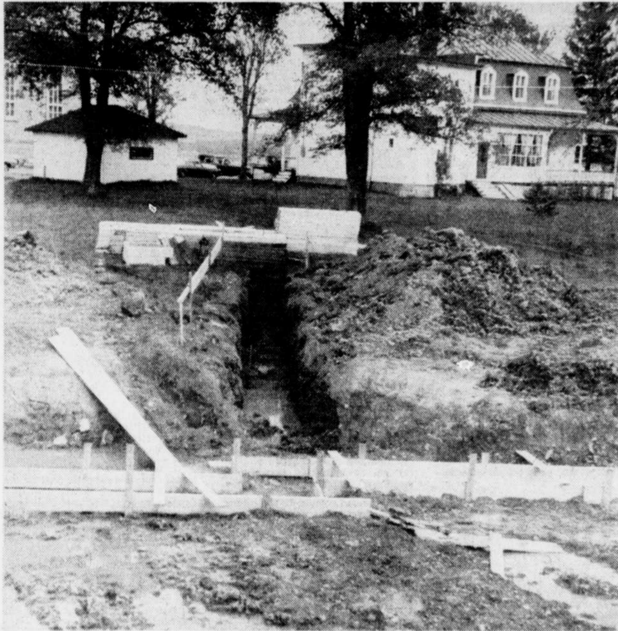
Sans attendre la décision finale de l'évêque, les paroissiens, partisans d'une construction neuve, ont creusé les fondations du nouveau presbytère à l'arrière de l'ancien déclaré monument historique.
