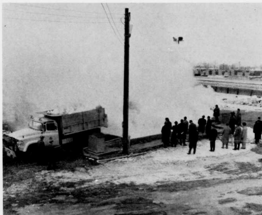
La fondeur à neige d'Outremont est en mesure de fondre 127 tonnes de glace à l'heure.
