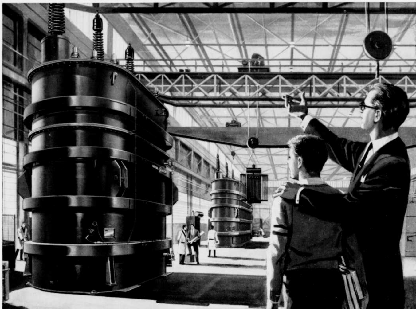
Usine des transformateurs C.G.E. à Guelph, Ontario
