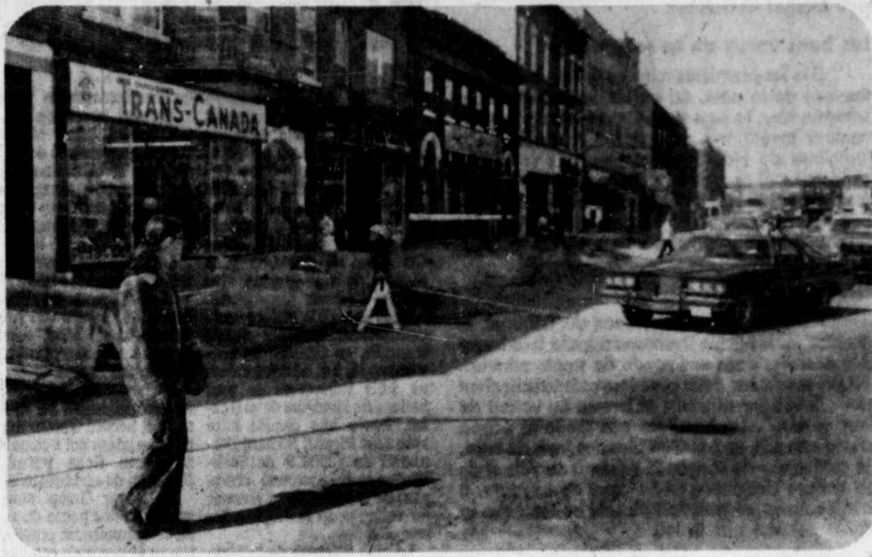
Dans le centre-ville de Shawinigan, l'activité fébrile chez les ouvriers est remarquée de tous alors que les travaux se sont accélérés au point que l'entrepreneur Sylvio Gendron a une avance d'un mois sur l'échéancier prévu pour le mois de juin. De l'ordre de $400,000 le projet est entièrement financé par le gouvernement fédéral (MEER). Sur la photo, nous remarquons la 5e rue et précisément de multiples carreaux
