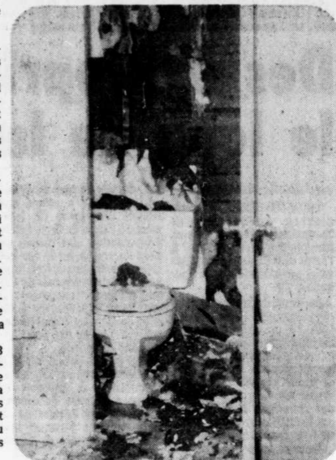
C'est dans une chambre de bains du second étage que le feu a fait le plus de dégâts. La boutique Florence située au rez-de-chaussée a été endommagée par l'eau et la fumée. (Photo Roland Lemire).
