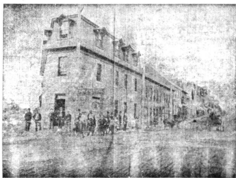
Cet Hotel le mieux Equips de la ville offre tout le confort desirable au public voyageur.
