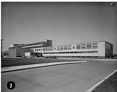
2 Les bâtiments de l'Institut de technologie Laval vers 1966. On note que l'aile qui joint présentement ces bâtiments à ceux de l'Institut des arts graphiques n'est pas encore construite. BAAnQ 06M E6 S7 SS1 P6 10240
