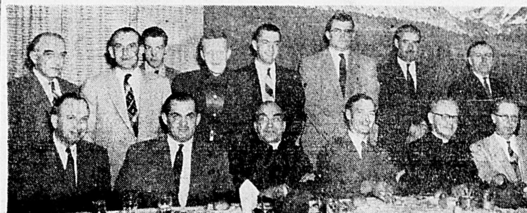
LES CHEVALIERS DE COLOMB CONSTRUENT UNE PISCINE A L'ORPHELINAT: — Les travaux sont commencés ce matin. Le comité réunit hier soir à l'hôtel Saguenay a décidé de procéder immédiatement. Les entrepreneurs consultés ont décidé de commencer au plus tôt. D'ici 15 jours, la piscine sera terminée. On voit ici assis de gauche à droite: Henri-Charles Savard, M. Emile Boileau, qui a reçu les membres du comité, l'abbé Adolphe Côté, aumônier de l'Orphelinat de l'Immaculée-Conception, M. Maurice-L. Laquerre, grand chevalier, l'abbé Bernard Nadeau, aumônier des Chevaliers, M. Alexis Desforges, président du comité. On reconnaît debout, MM. Maurice Gauthier, Ernest Dufour, J.-R. Turcotte, Johnny Simmonato, Algérie Savard, Charles-Arthur Lajoie, Georges Scanlan et Yvon Bélanger. (Photo "Le Progrès", par BLM).
