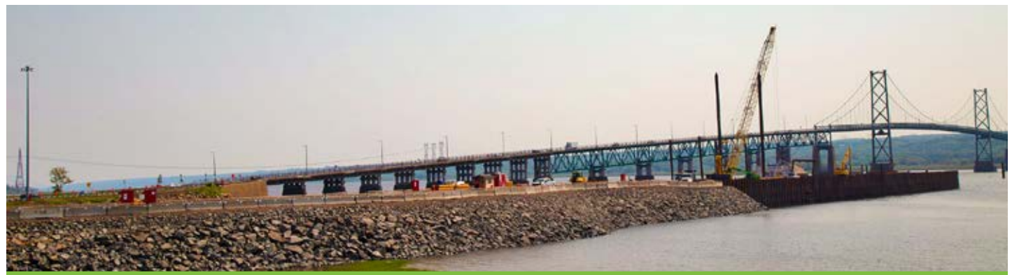
La jetée temporaire permettra d'effectuer des travaux en profondeur pour installer des pieux.
