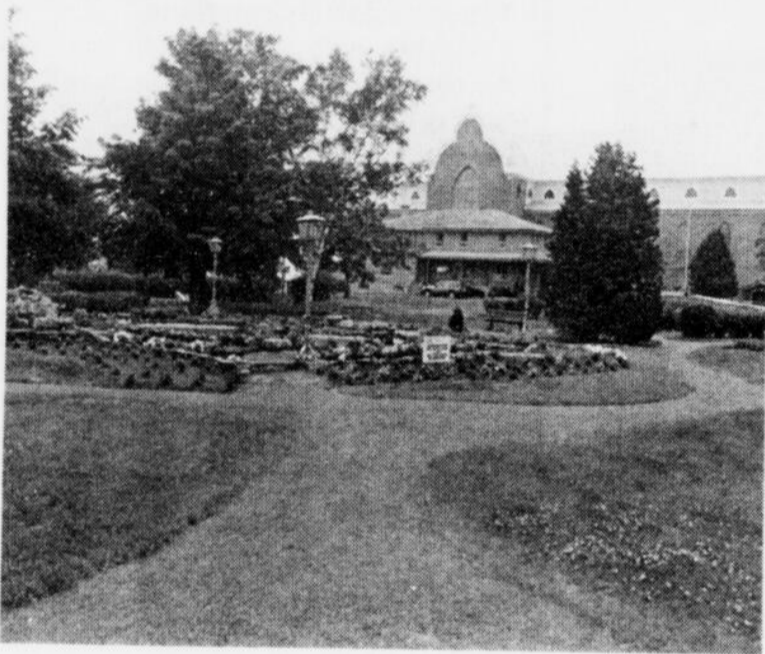
Voici une partie du parc de l'Église, tel qu'il se présente à la suite des travaux de restauration amorcés l'automne dernier et complétés récemment. On reconnaît le secteur du bassin hydrographique, un aménagement original qui reproduit le lac Saint-Jean et ses tributaires.
