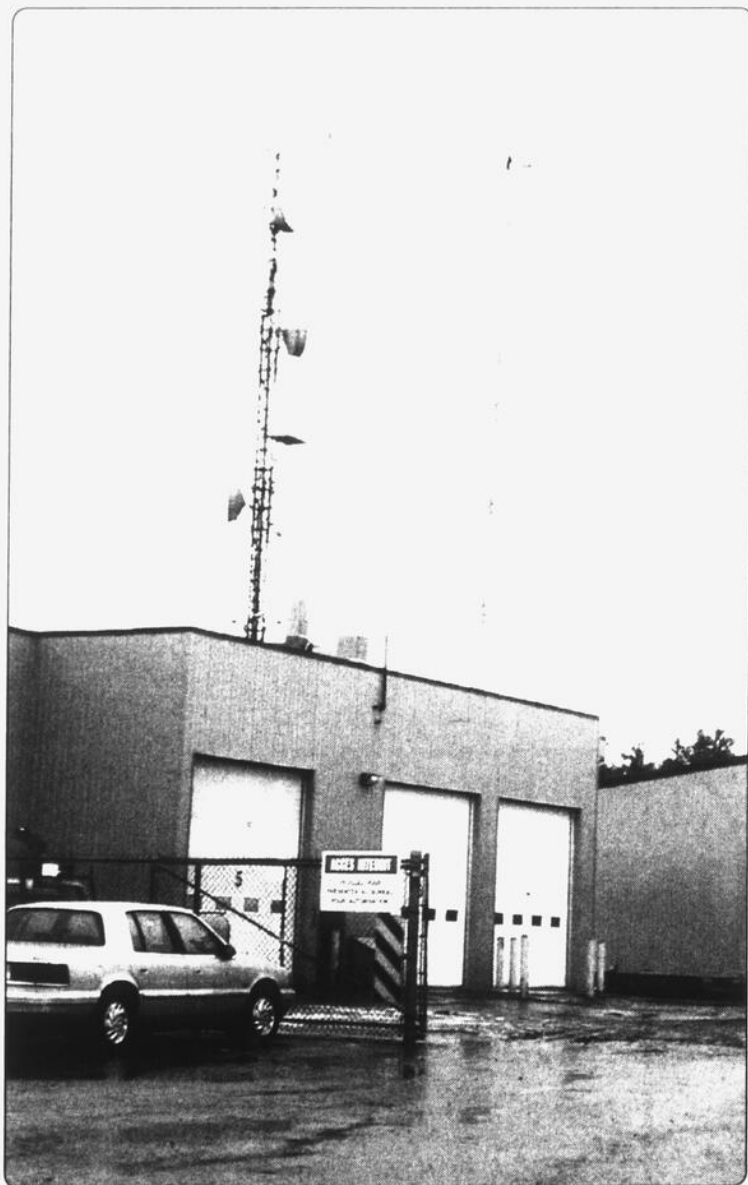
Les pylônes d'antennes déparent parfois le paysage.
