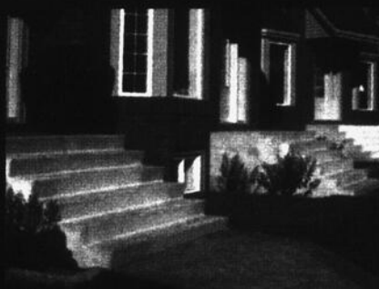
perrons et dalles préfabriqués
