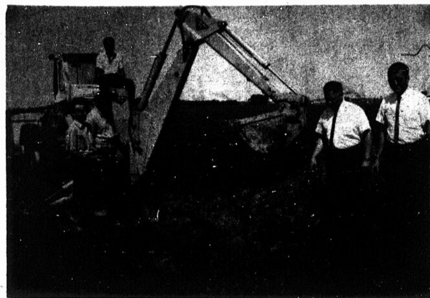
Les premiers sondages du terrain devant servir à l'érection d'une aérogare à Saint-Jean avaient lieu mardi matin, en présence de MM. Jacques Laporte, président du Comité Air Saint-Jean, Pierre Berger surintendant des travaux, Marcel Bernard, ingénieur municipal, et Yves Gaudette, de la firme Monarque, Gaudette, Morelli et Laporte.
